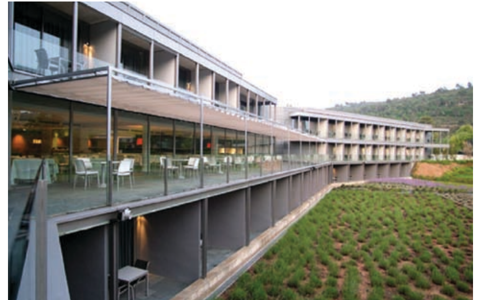
Hotel Món, després de la seva inauguració, amb vistes a les terrasses de les habitacions.
