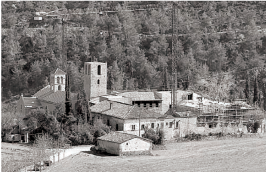
Fotografia del complex l'any 2006, en obres.
